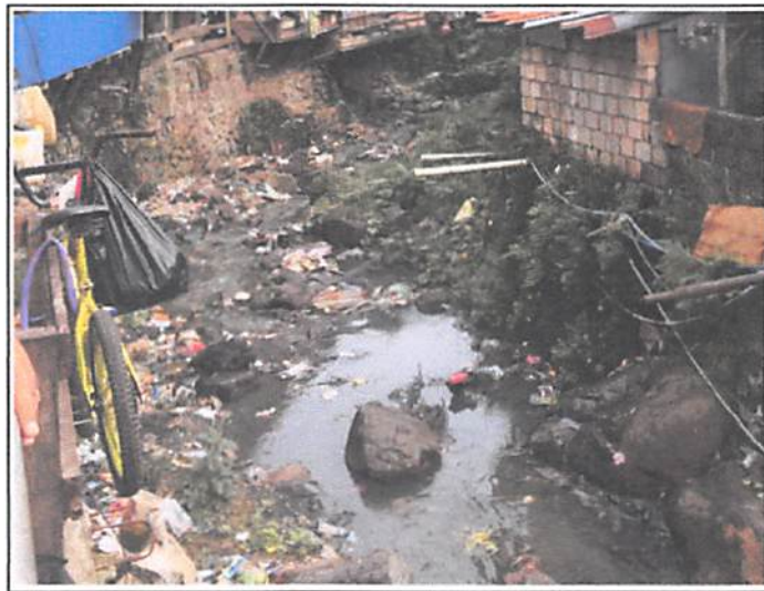
Gambar 9. Contoh Kondisi Saluran Pasangan Batu yang Rusak (Sumber: Peraturan Menteri Pekerjaan Umum Nomor: 14/PRT/M/2018)
