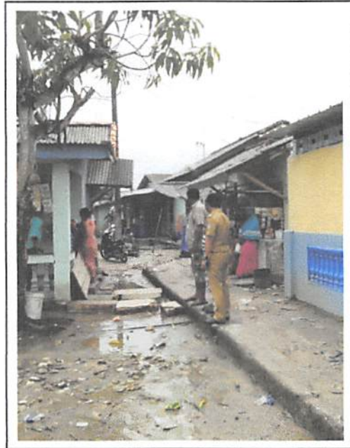
Gambar 4. Contoh Kondisi Perumahan yang Tidak Terlayani Jalan Lingkungan
